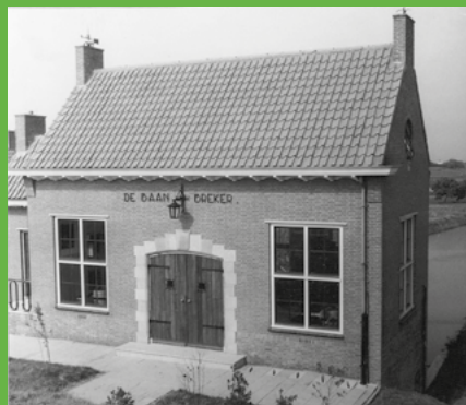
Gemaal De Baanbreker in Wellseind in 1952. Bron: 3500-10-1045
